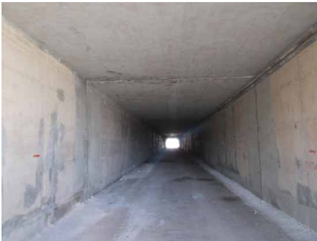
Εργασίες επιδιόρθωσης στο τεχνικό (ΓΕ 1-15)
