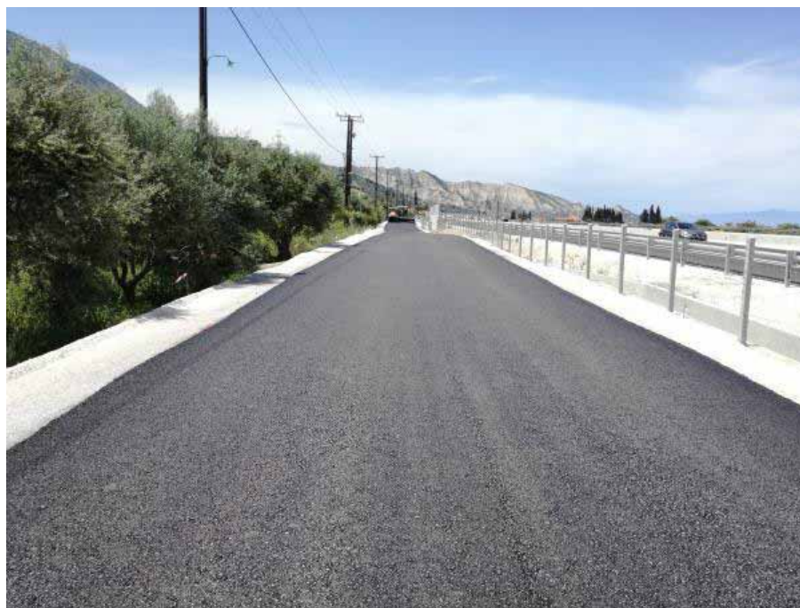
SR033L – Εργασίες ασφαλτόστρωσης σε παράλευρη οδό
