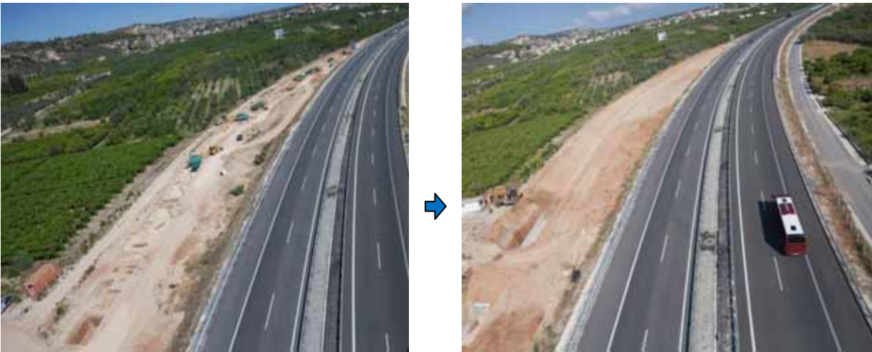
Εργασίες στον Αρχαιολογικό χώρο Ασωπού – Μουλίκι (ΧΘ 17+200, παράδρομος)
