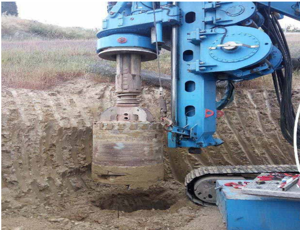
0530 53+174-53+247 L.B.: γεωτρήσεις για την τοποθέτηση κολώνων
