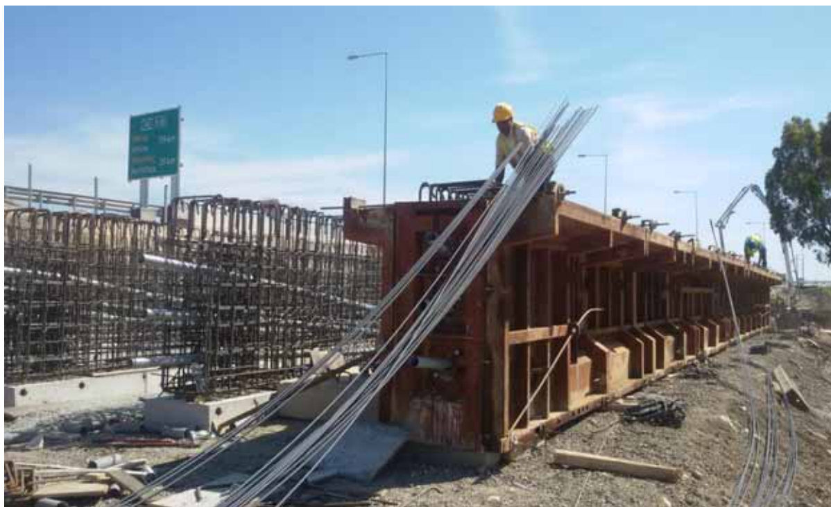
B211 (SR KP 32+763) – προκατασκευή στοιχείων γέφυρας
