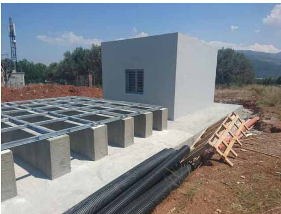
Κατασκευή υποδομών γεώτρησης στη χ.θ. 88+040
