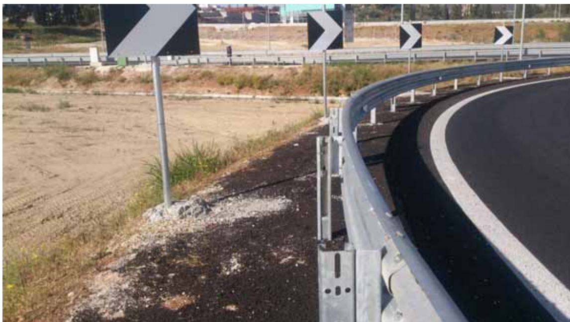
Εγκατάσταση πινακίδων σήμανσης
