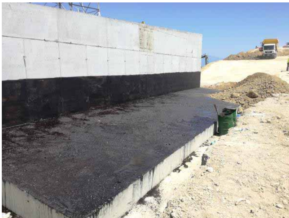
R293 – Κατασκευή τοιχίου αντιστήριξης
