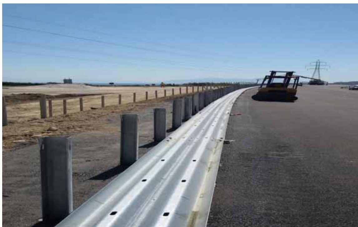
Κ.ρ. 33+300-37+000 R.B. – Εγκατάσταση στηθαίων ασφαλείας
