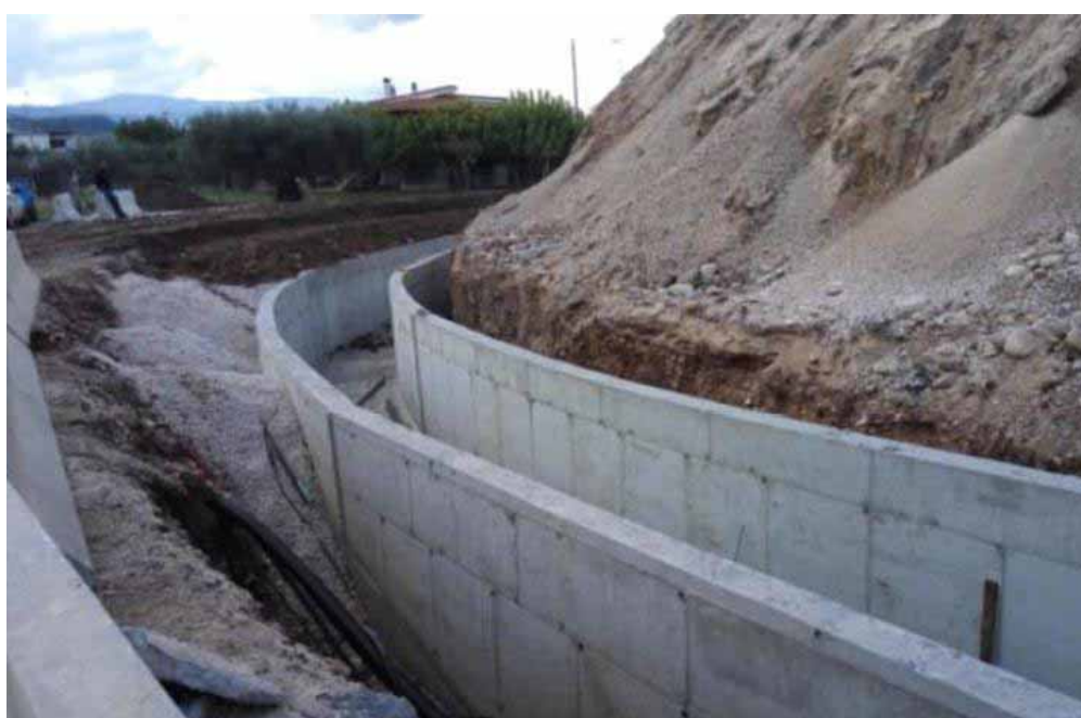
Κατασκευή δικτύου αποστράγγισης στο ΣΕΑ ΑΙΓΙΟΥ
