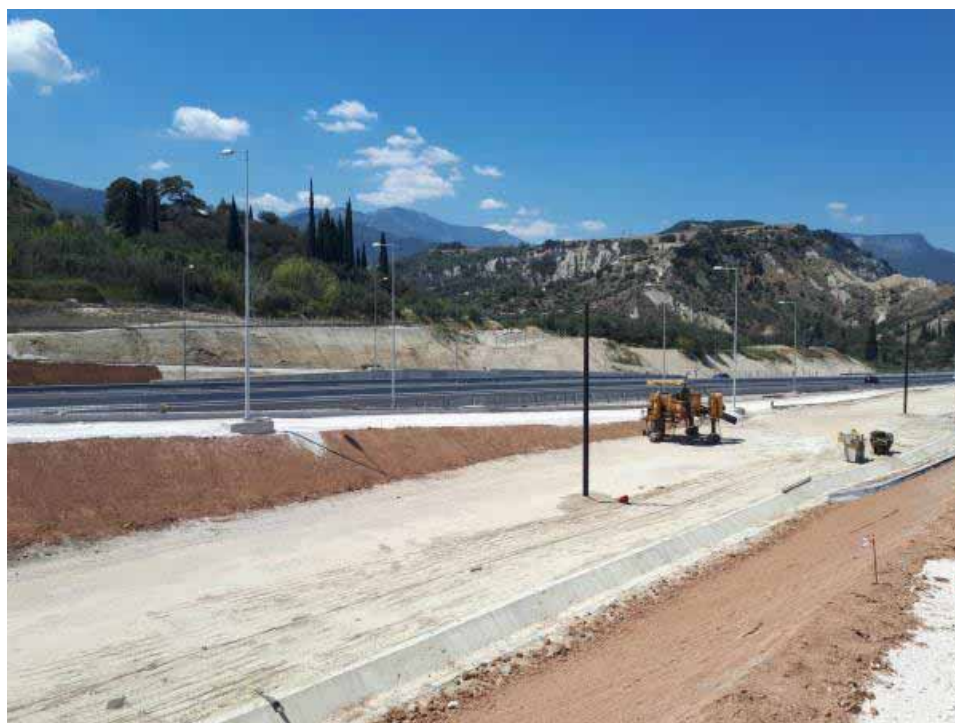
Κόμβος Λυκοποριάς : Εγκατάσταση, καλωδιώσεων, βάσεων και στηλών φωτισμού
