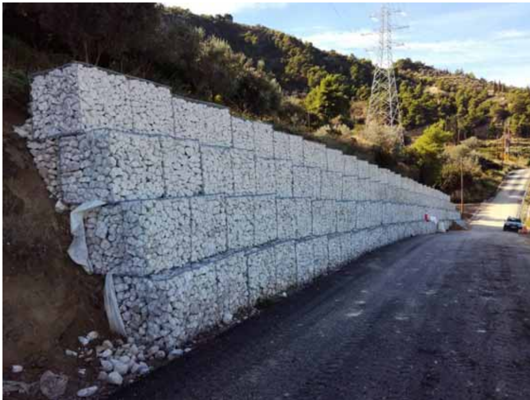
Κατασκευή τοιχείου αντιστήριξης με σαρσανέτια
